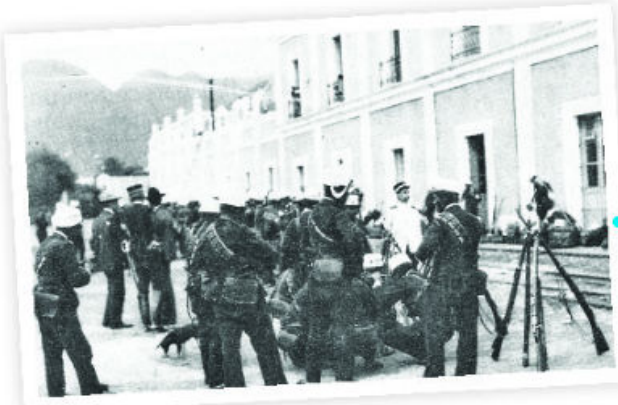
Figura 3.19 La policía rodea la fábrica de Río Blanco. La Constitución de 1857 no hace referencia a los derechos de los trabajadores. Habla sólo del derecho al trabajo.
